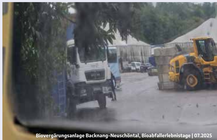
Biovergärungsanlage Backnang-Neuschöntal, Bioabfallerlebnistage | 07.2025
